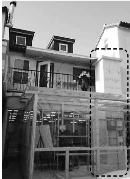
図3 山側の厨房と食堂
